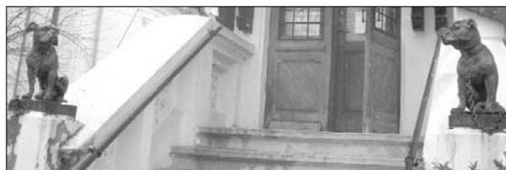
Casa „Codreanu” are noroc de Bolta Rece și de doi buldogi
